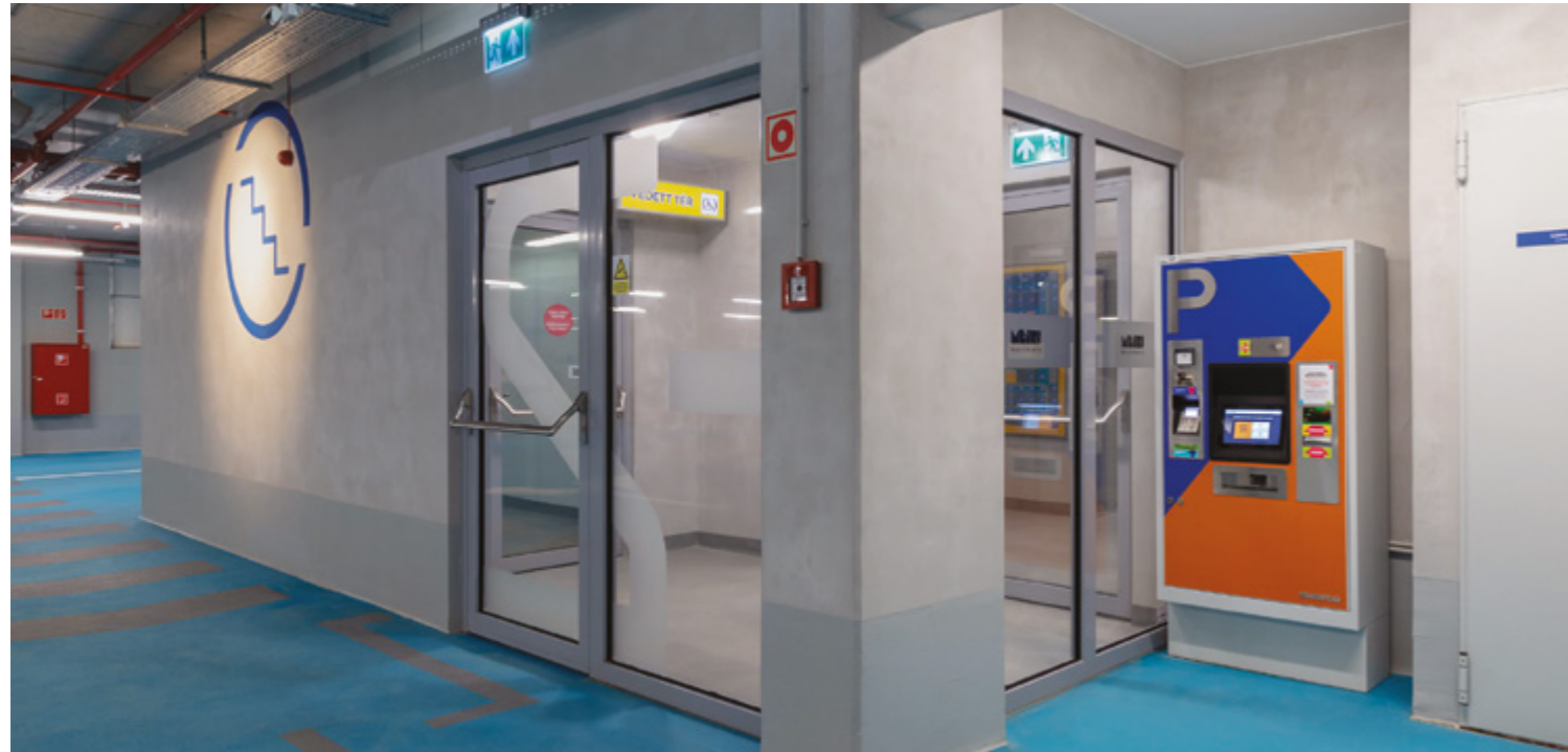
Coolfire-Sapa 74 - E160 tűzgátló üvegajtó, oldalvilágítóval, fix elemekkel Coolfire-Sapa 50 - S200 füstgátló üvegajtó • C5 intenzív használat (200ezer nyitásciklus) • pánikfunkció – GU rozsdamentes pánokrúddal
