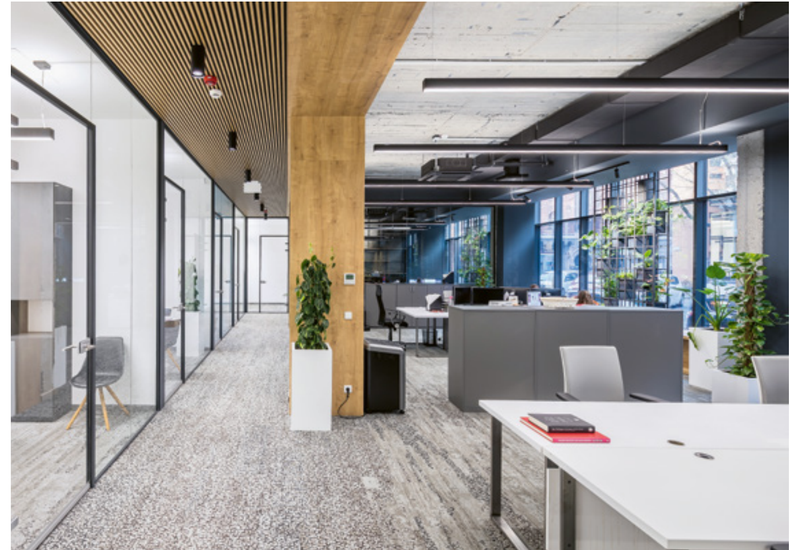
A látszóbeton burkolat egy része a visszabontáskor jó állapotban talált betonfödém kiegészítése
