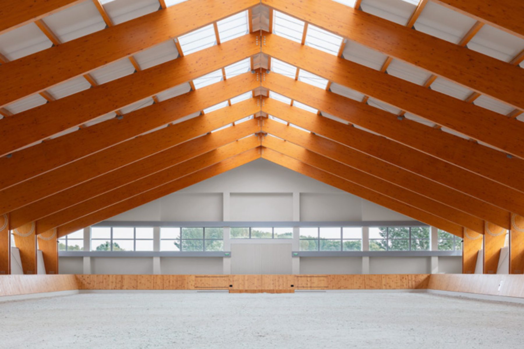
A ragasztott fatartók különleges és látványos, hatalmas ízületre emlékeztető összeerősítése oldja meg a viszonylag nagy fesztáv szellősen nagyvonalú, mégis erőt és szilárdságot sugárzó áthidalását
